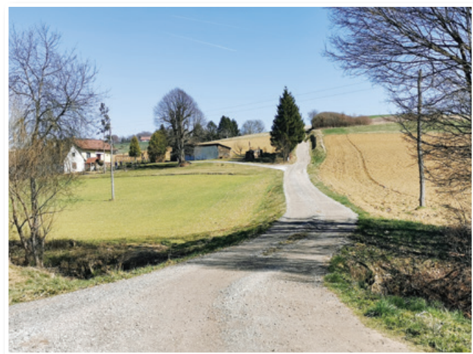
Eden izmed sklopov rekonstrukcije občinskih cest faza 4 bo tudi asfaltiranje cestnega odseka v Zg. Partinju. Foto: Dejan Kramberger
